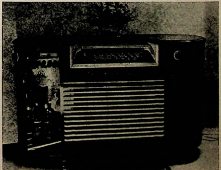
Eine hübsche Konstruktionsidee war an dem Rema 664 W zu sehen. Die Skalenlampe und die Skala selbst können durch einfaches Verschieben der Holzklötze herausgenommen werden
